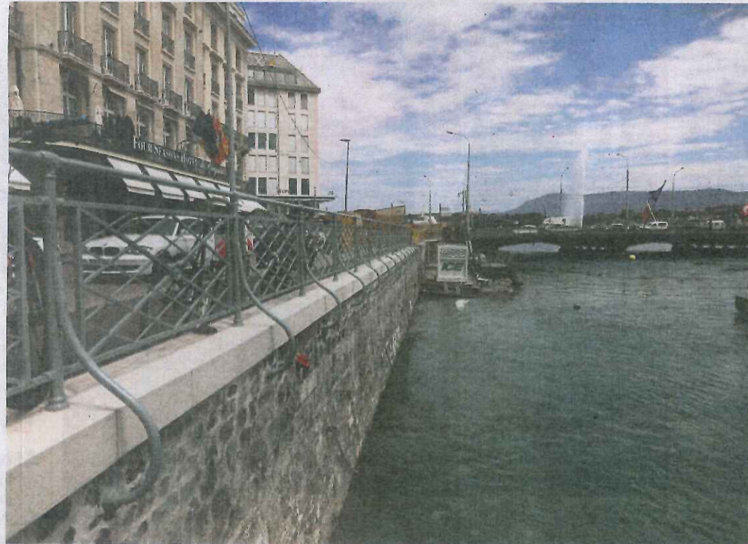
A gauche, le quai des Bergues révèle son nouveau visage sur sa partie orientale, avec ses pierres de taille, leur couronnement en calcaire et une barrière conforme à la tradition genevoise. A droite, les poutres quadrangulaires de l'ancien encorbellement vivent leurs derniers jours à l'ouest du quai. GEORGES CABRERA
