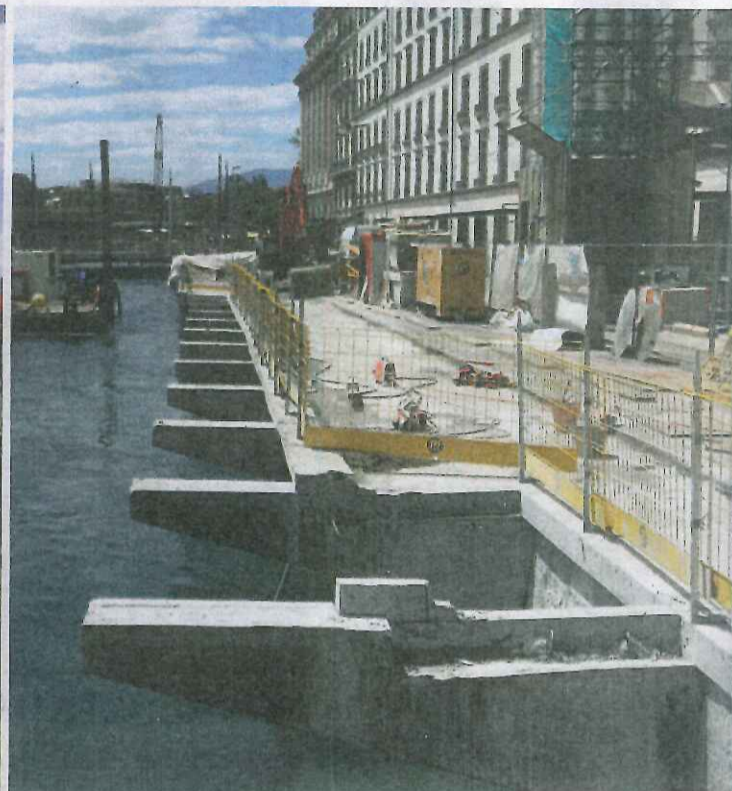
A gauche, le quai des Bergues révèle son nouveau visage sur sa partie orientale, avec ses pierres de taille, leur couronnement en calcaire et une barrière conforme à la tradition genevoise. A droite, les poutres quadrangulaires de l'ancien encorbellement vivent leurs derniers jours à l'ouest du quai. GEORGES CABRERA
