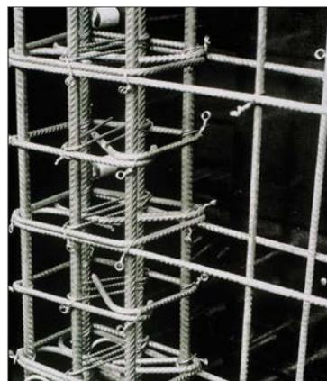
*Armature d'une paroi parasismique en béton armé (tiré de [4]). Les détails constructifs et la qualité de l'exécution jouent un rôle crucial dans le comportement des ouvrages soumis à un séisme.*
