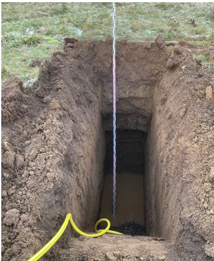
Immeuble Pommeraie 8 Thônex 2020
