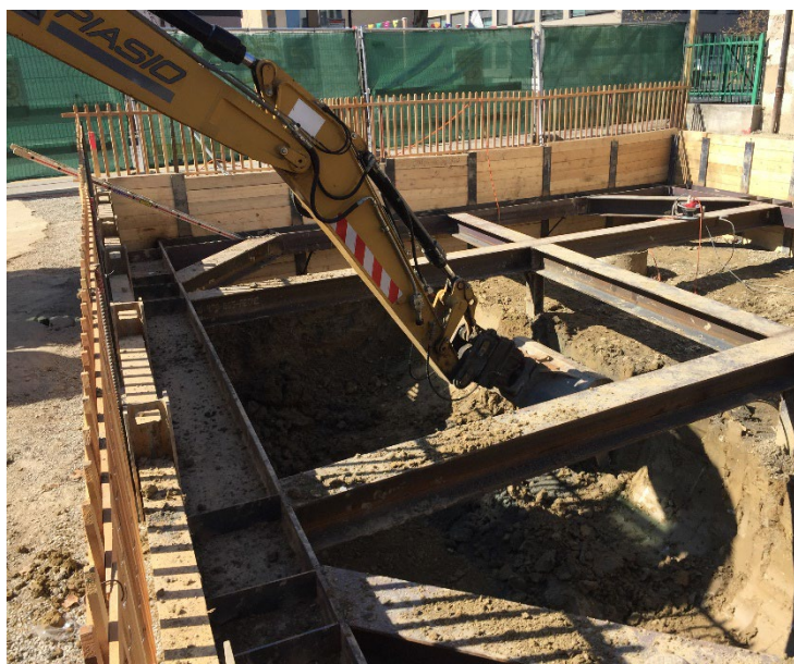
Dépollution station essence et garage de Veyrier 2019
