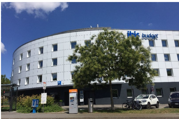
Lancy Square – Bâtiment hôtelier 2009 - 2010
