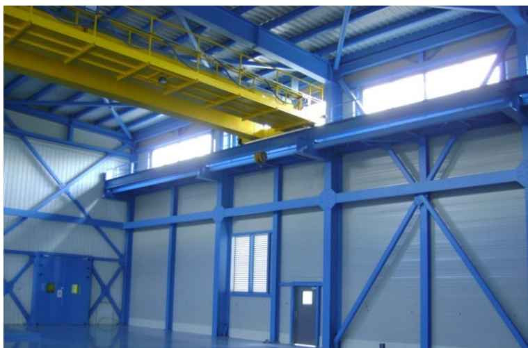
CERN – Bât. Elena, Meyrin Structure métallique - 2014
