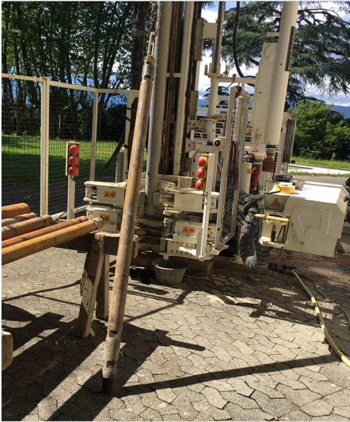
Construction ch. des Marèches Vésenaz 2021
