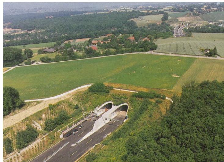
Tranchée couverte de Chèvres Bernex / GE 1988 - 1992
