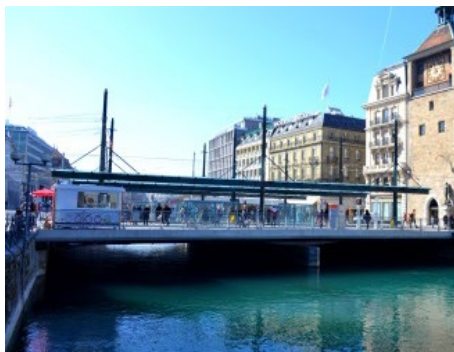
Démolition et reconstruction des Ponts de l'Ile - 2008-2011
