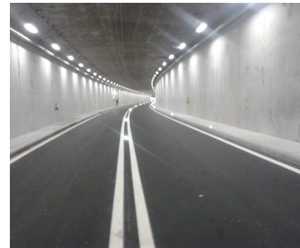
Tranchée couverte de Vésenaz 2011-2014
